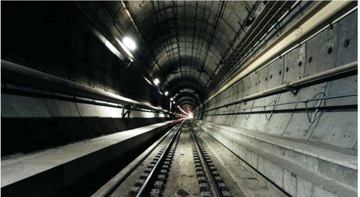
사용 중인 터널 중 하나의 내부
